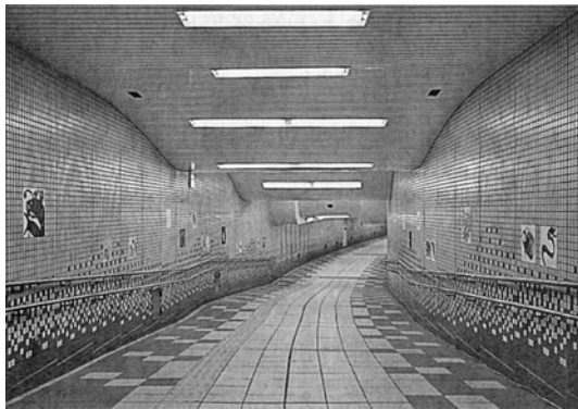
駒ヶ林駅地下通路の壁面タイル
