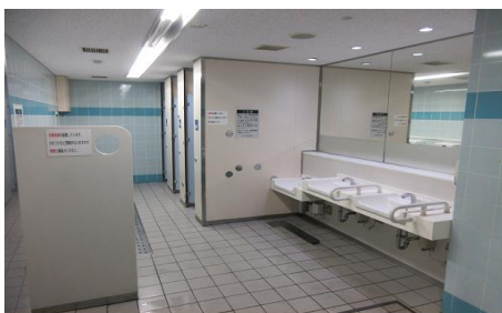
▲名谷駅トイレ高質化工事 (工事前)
