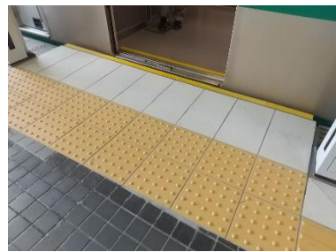
▲隙間・段差解消後
