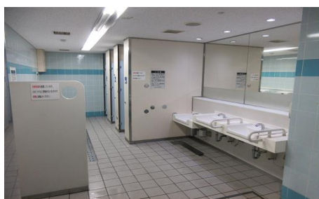
▲名谷駅トイレ高質化工事 (工事前)
