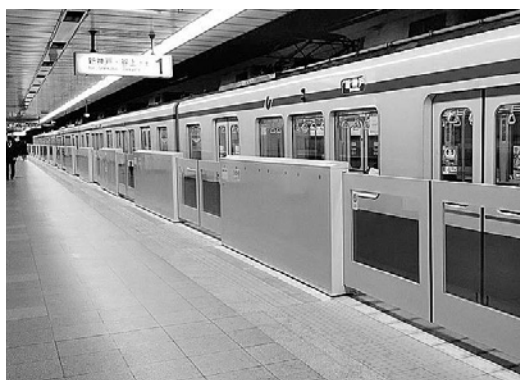
三宮駅ホームドア設置状況
