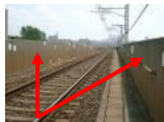
コンクリート壁 （西神・山手線 高架部）
