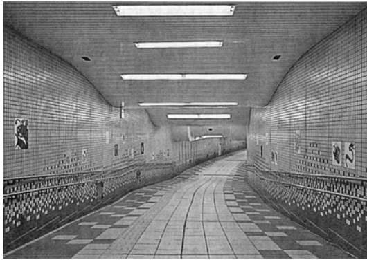
駒ヶ林駅地下通路の壁面タイル
