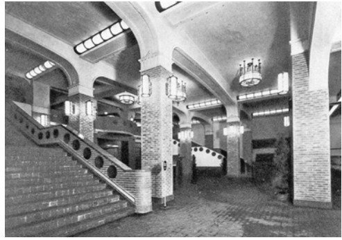
昭和8（1933）年6月完成した阪神電車三宮駅の中央階段
