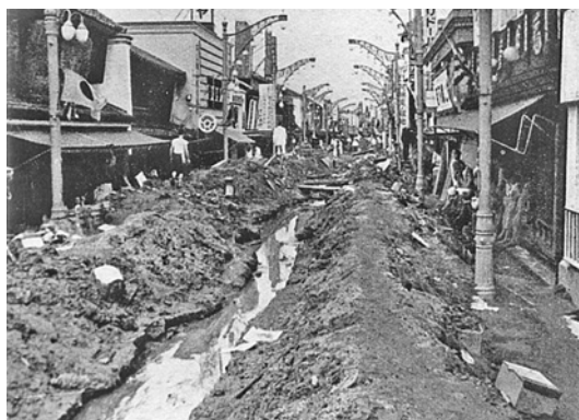
泥土の山となった元町通
