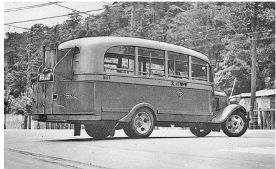
陸式川崎型ガス発生炉取付車（新バス）
