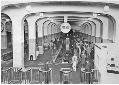
地下鉄乗入れ前の阪神三宮駅終点 地下鉄としては日本一の規模であった
