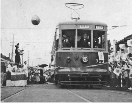
石屋川線全通（昭和28（1953）年）
