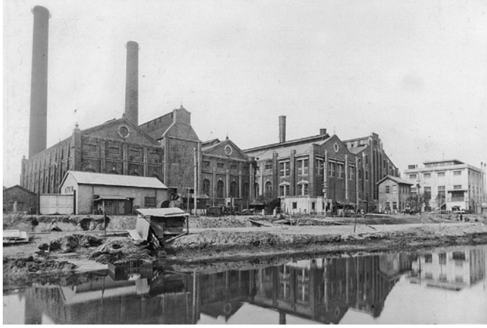
湊川発電所全景
