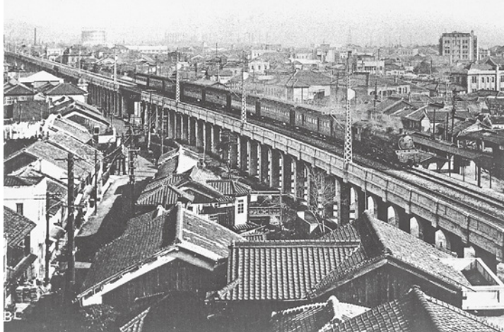
完成直後の省線高架三ノ宮駅付近
