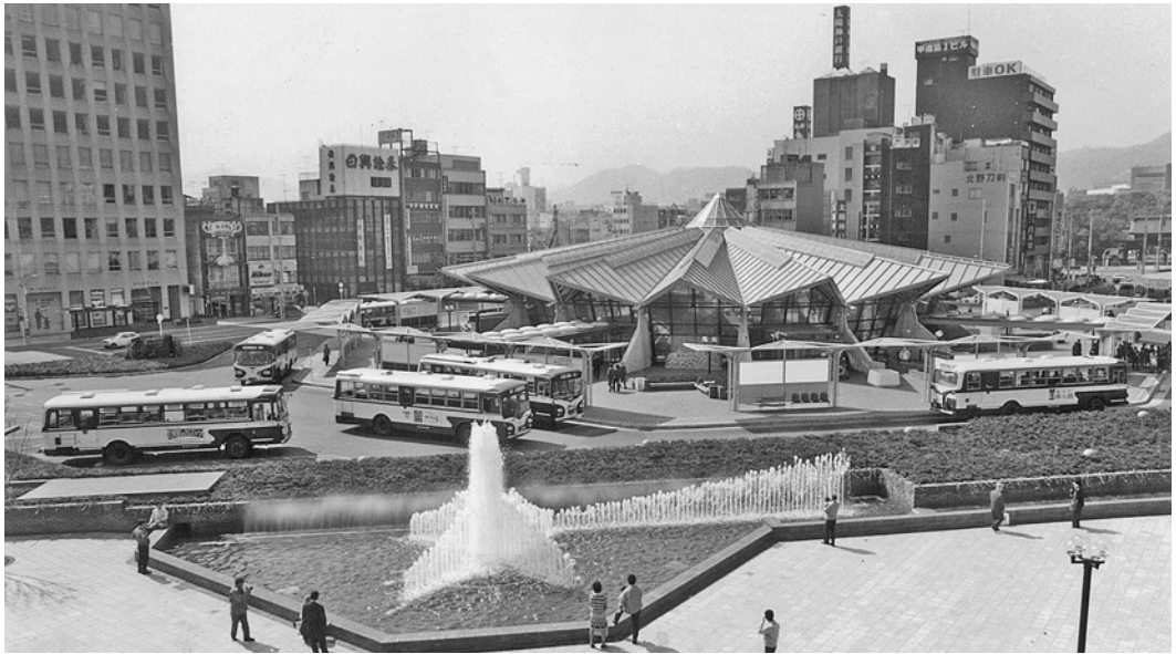
神戸駅前バスターミナルの着工から完成まで
