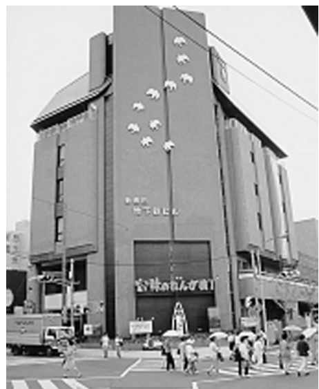
神戸交通振興(株)が入居する新長田地下鉄ビル
