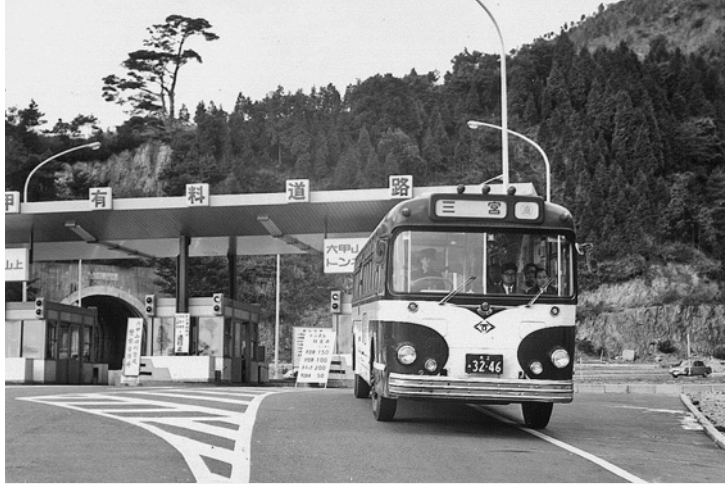
第1六甲トンネル開通 で文字どおり直通とな った有馬線 (六甲有料道路入口)
