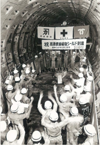
西神線掘削工事 (昭和50(1975)年6月)
