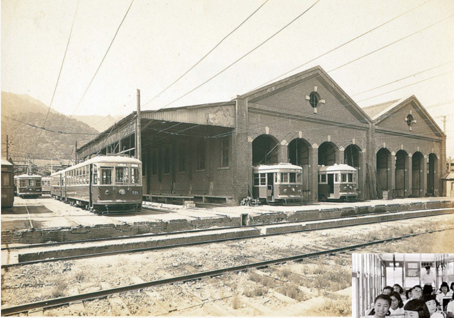
復旧した布引車庫 (昭和23 (1948) 年)
