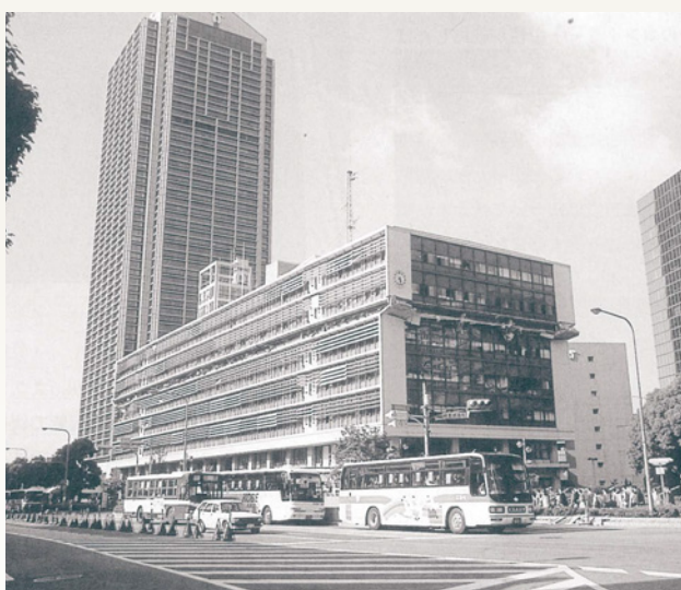
地震によって6階部分が崩壊した神戸市役所2号館と代替バス
