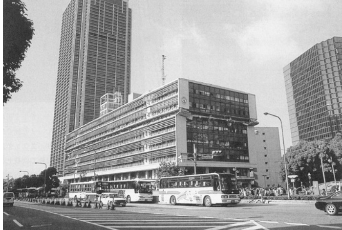
崩れた神戸市役所2号館と代替バス
