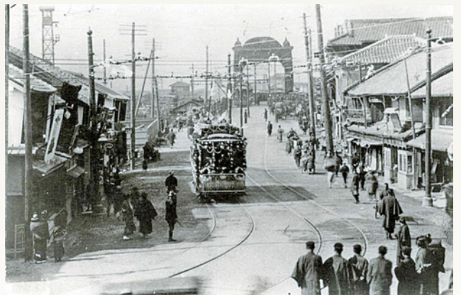
三越西の相生橋付近を走る開業電車 (明治43 (1910) 年)
