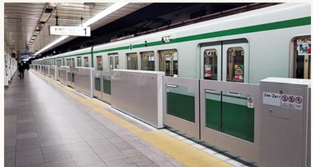
平成30(2018)年3月から稼働した三宮駅のホームドア。 令和5(2023)年度までに西神・山手線の全駅で設置をめざす
