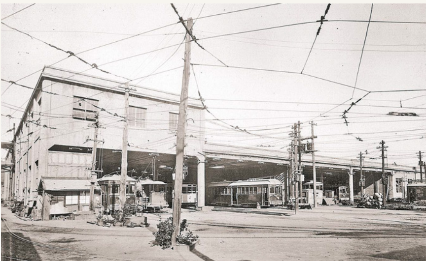
用水池を埋め立てて 建設された長田工場 (大正11 (1922) 年)
