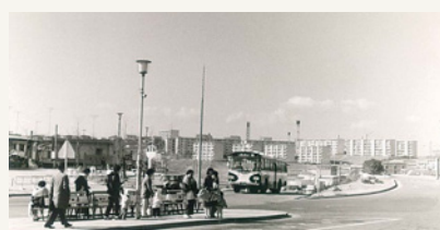
西神戸のマンモス団地多間台線が開通 (多間団地センター) (昭和41 (1966) 年)
