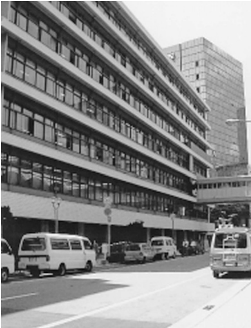
交通局本庁舎ビル（市役所3号館）
