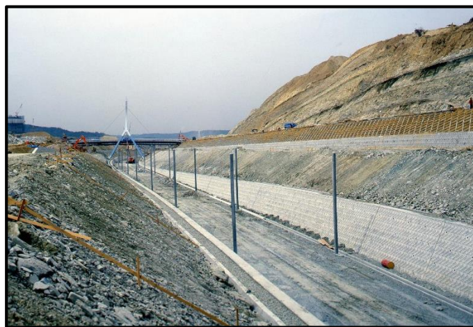
建設中の学園都市駅付近
